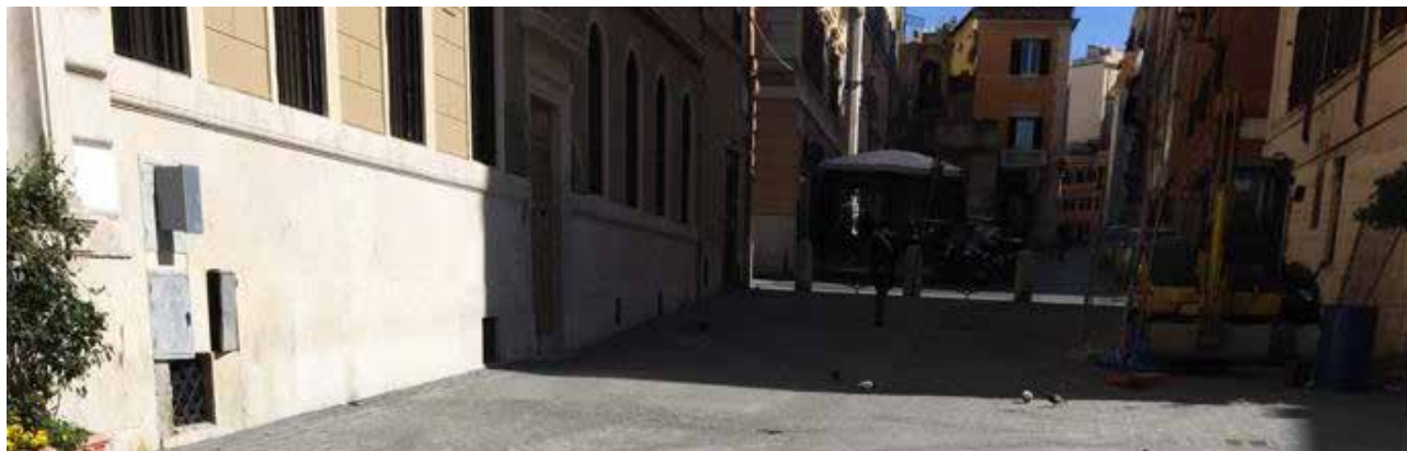
Nella foto le immagini del cantiere di piazza della Madonna dei Monti prima dello stop dei lavori
